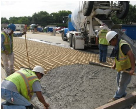
Grasscrete Concrete Pour
