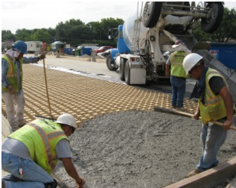
Grasscrete Concrete Pour
