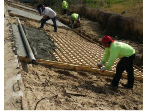
Jean LaFitte Auditorium - Grasscrete Concrete Pour Installation
