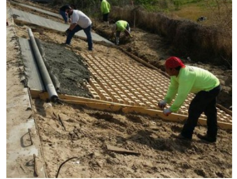
Jean LaFitte Auditorium - Grasscrete Concrete Pour Installation
