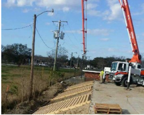
Jean LaFitte Auditorium - Grasscrete Concrete pour Installation
