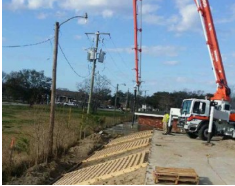
Jean LaFitte Auditorium - Grasscrete Concrete pour Installation
