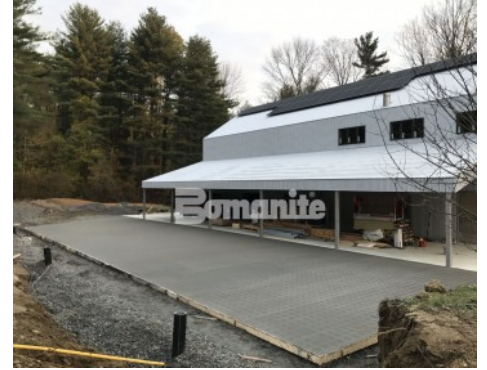
Concrete Pour over Molded Pulp Formers
